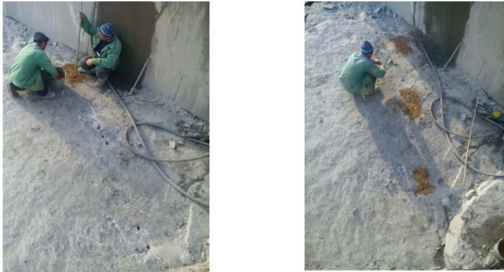
Рис. 1.1. Процес заряджання шпурів газогенератором «Літокол»
