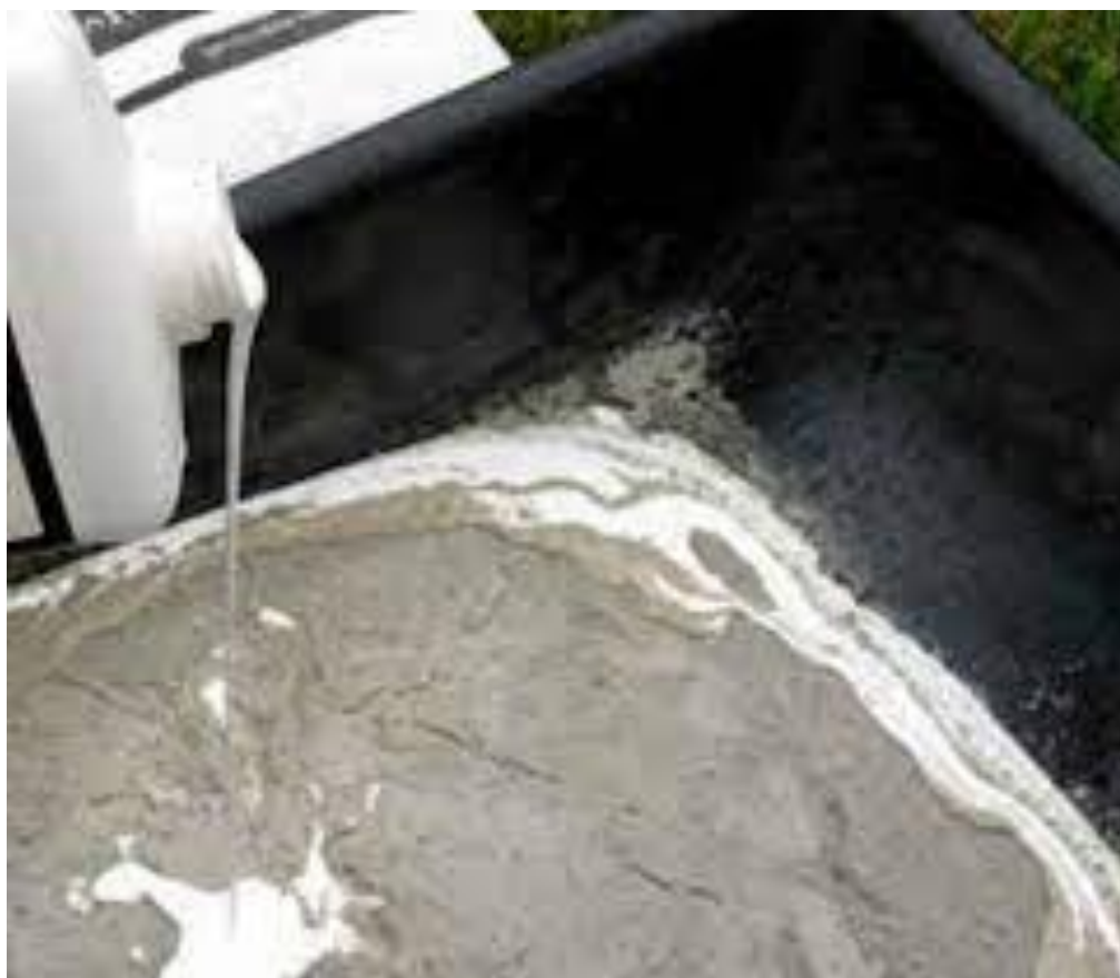
Рис. 2.5. Процес додавання суперпластифікатора DYNAMON XTEND W202 R
