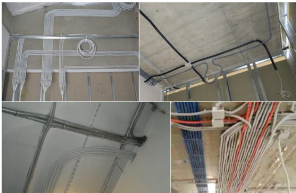
Рисунок 2.11 – Монтаж кабельних ліній системи відеоспостереження
