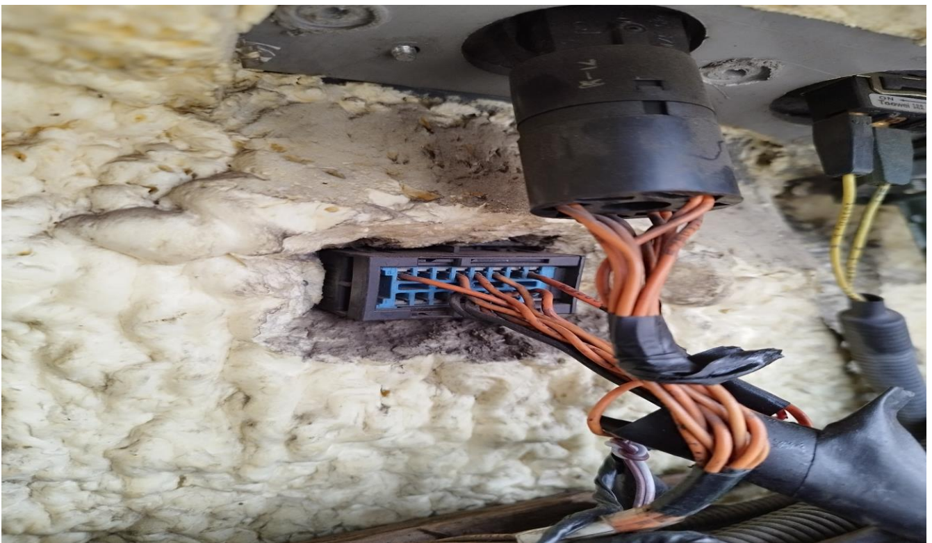
Рис 3.12 Монтаж трекера до проводів CAN з зовнішнього боку діагностичного роз'єму автобуса МАЗ 206086
