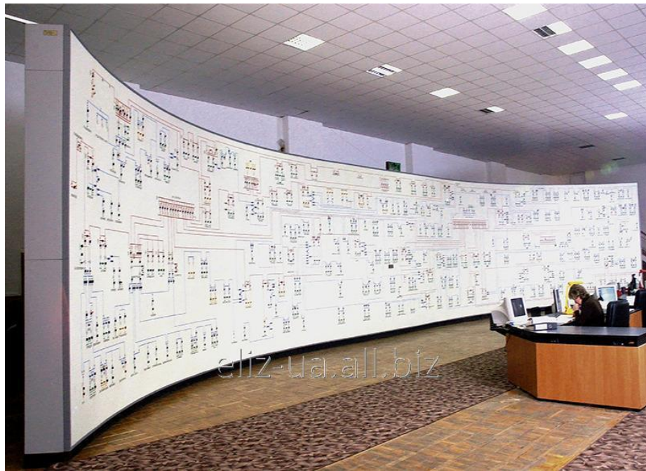
Рис1.3. Диспетчерські щит ферромагнієвий завод (Казахстан)
