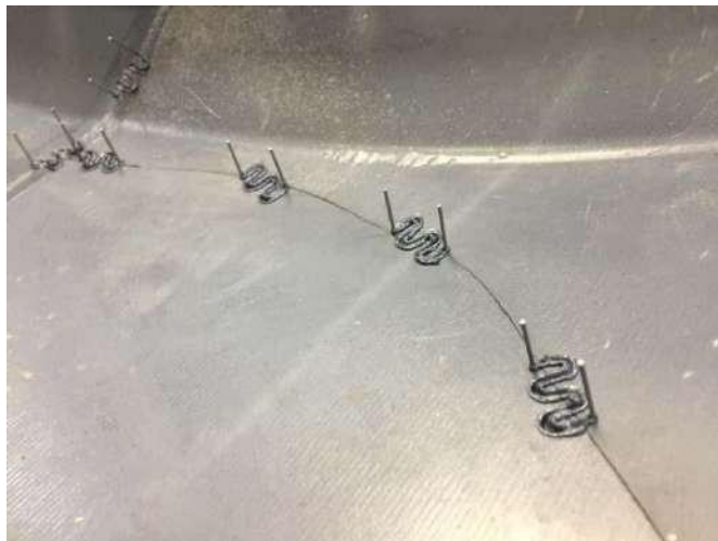
Рисунок 1.9 – Відновлення деталі нагрітим елементом
