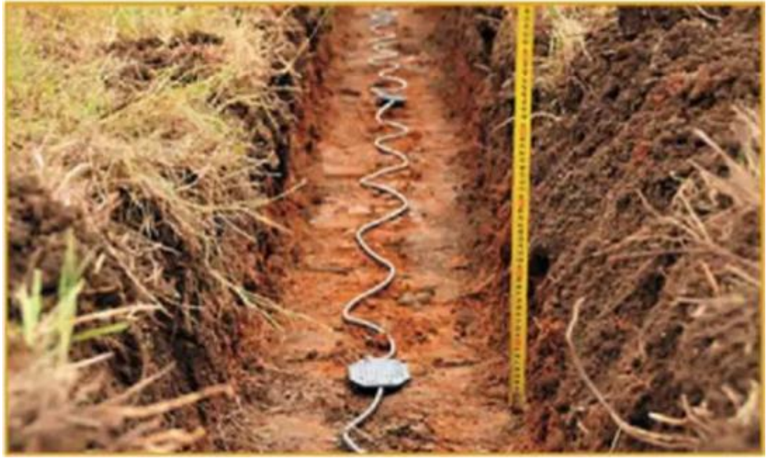
Рисунок 1.7 – Вигляд встановлення сенсорних кабелів
