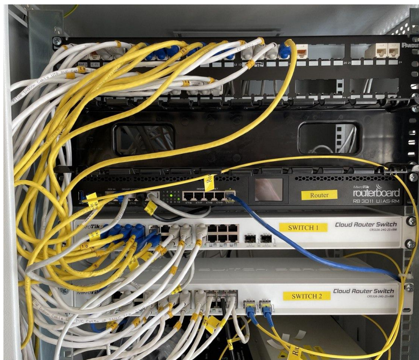
Рисунок 3.16 – Зображення вдалого підключення, налаштування та підписання всіх портів та проводів першого ящика у першому корпусі
