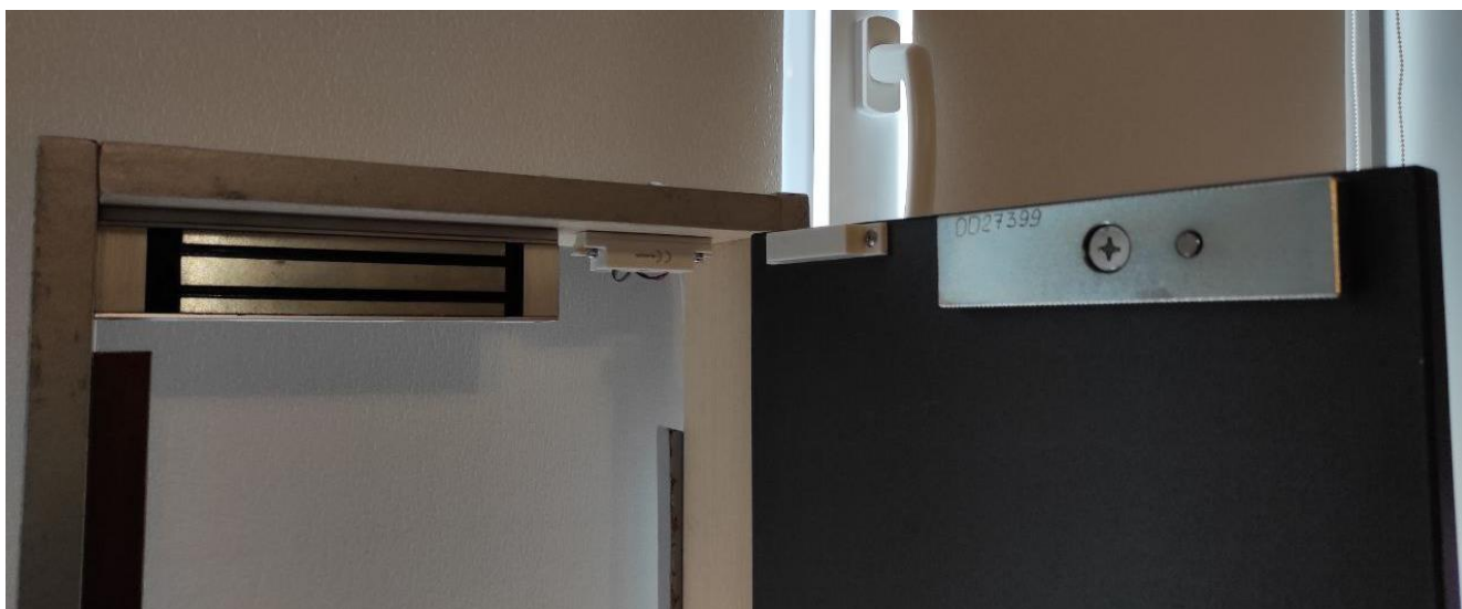
Рис.3.6 Результат встановлення та підключення електромагнітного замка та датчику стану дверей
