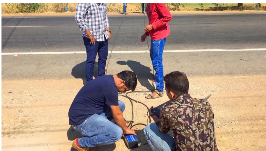
Рисунок 3.2 – Процес монтажу дорожніх датчиків
