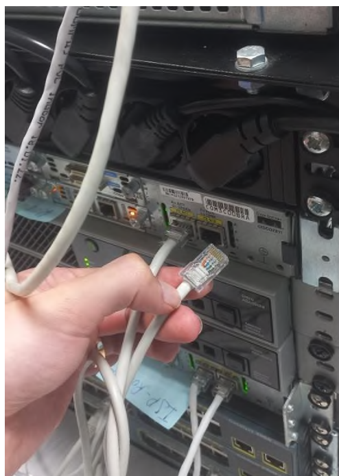
Рисунок 2.6.56 – Роз'єднання фізичного з'єднання між маршрутизатором R-8-11-2 та комутатором SW-8-11-2.
