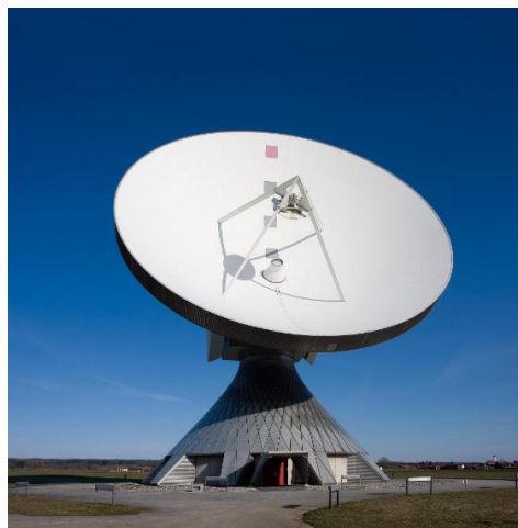
Рисунок 2.1—Параболічна дзеркальна антена
